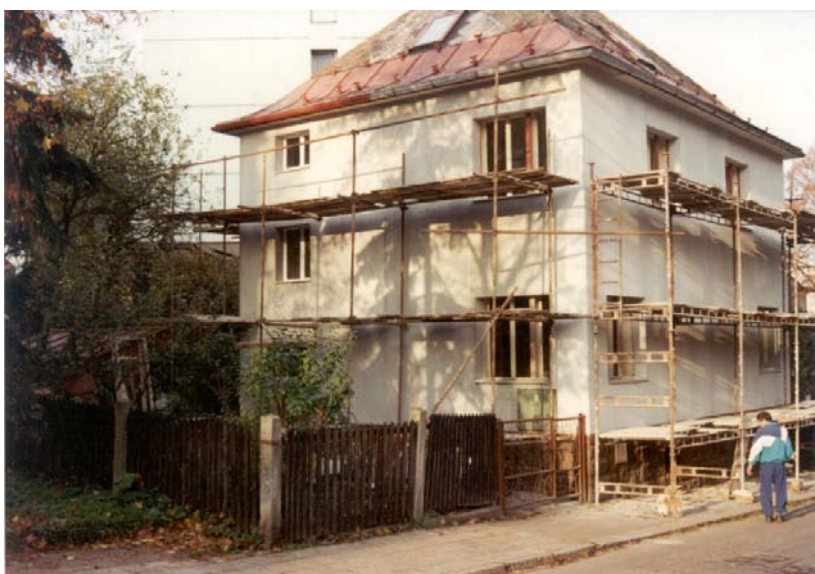
Obr. 5 - Pravá část lešení „Haki“, levá část trubkové lešení; lešení vyazuje hrubé závady, které ohrožují život a zdraví pracovníků
