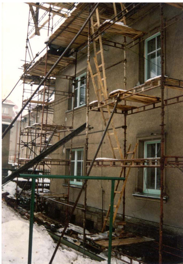
Obr. 4 - Lešení dílcové „HAKI“ kombinované s trubkovým lešením vykazující hrubé konstrukční závady a bezpečnostní nedostatky (chybí úhlopříčné podélné ztužení, vzpěry nejsou provedeny v souladu s normou, výstupní žebříky neodpovídají normovým požadavkům, chybí ochranné zábradlí se zarážkou u podlahy)
