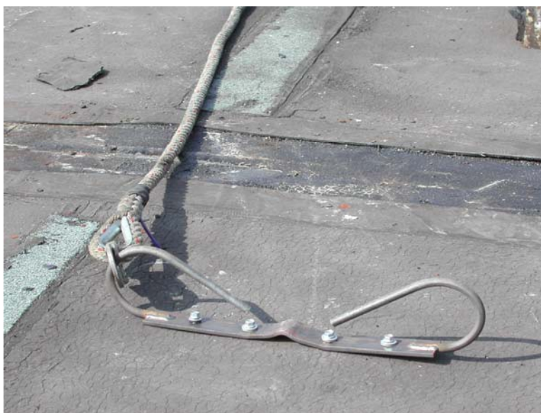
Obr. 6 - Příklad kotvení OOPP proti pádu, u kterého není prokázána únosnost
